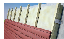
Colocación de una protección contra la lluvia
