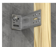
Fijación de cabrios de madera
