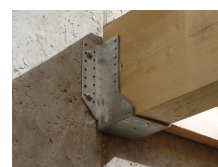
Fixation de structure bois
