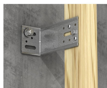
Fijación de cabrios de madera
