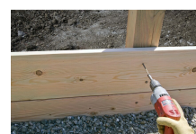
Fijación de elementos de madera en el exterior
