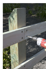
Fijación de empalizadas
