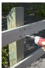
Fijación de empalizadas
