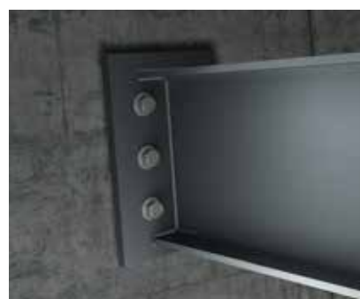
Fijación de ménsulas, pletinas y vigas de acero
