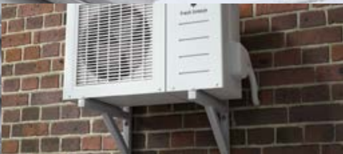
INSTALACIÓN DE CALEFACCIÓN Y FONTANERÍA
